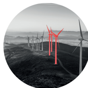
INSTALLAZIONI SOLARI ED EOLICHE SOLAR AND WIND INSTALLATIONS
